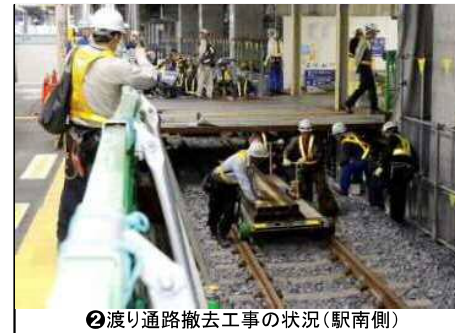
②渡り通路撤去工事の状況(駅南側)
