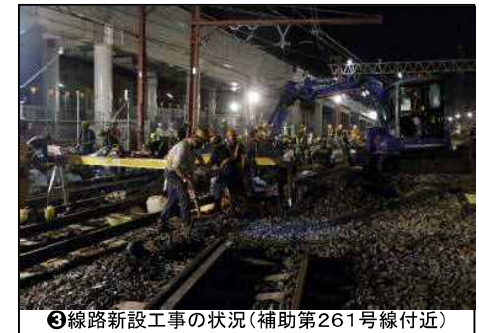
③線路新設工事の状況(補助第261号線付近)
