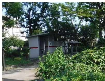
既存トイレ(撤去予定)
