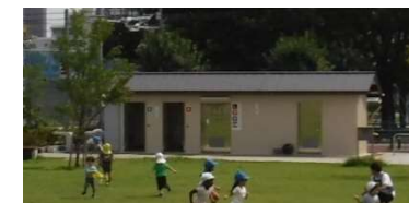
だれでもトイレ(H30建設)
