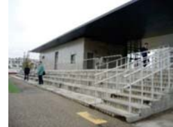
クラブハウス事例 (東京理科大学/葛飾区)
