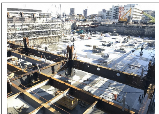
病院棟：地下躯体工事
