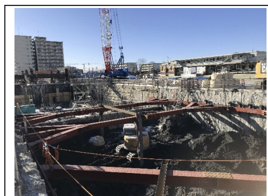
学校・寮棟：掘削工事
