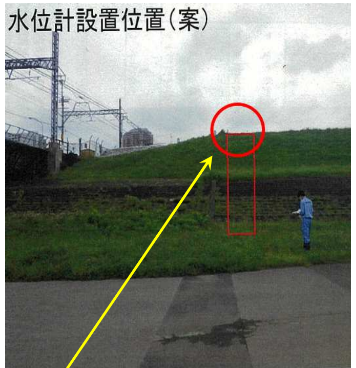
堤防天端に水位計を新設する
