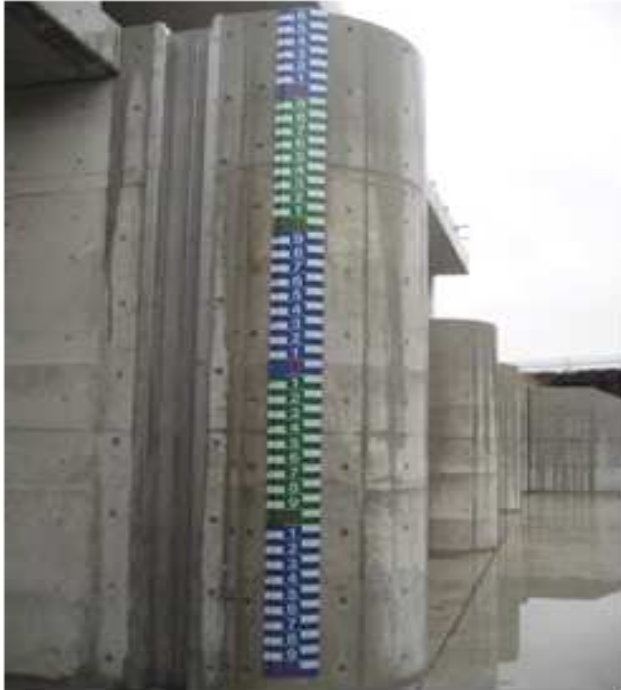
岡山県管轄 八番水門
