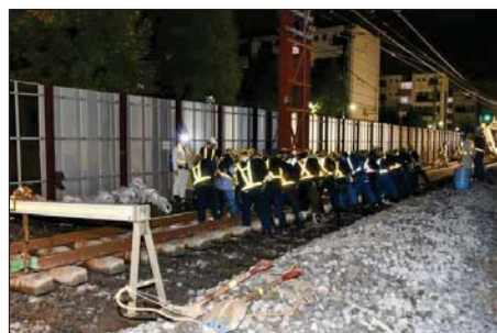
①竹の塚一丁目付近線路切替工事の状況
