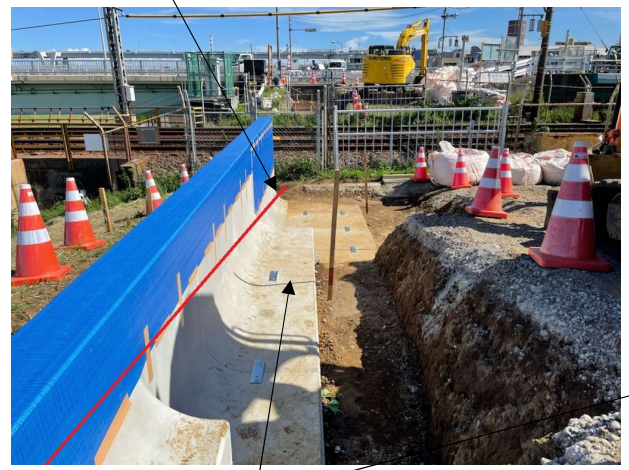
L型の擁壁底部を河川の外側から固定し、水圧に耐える構造
