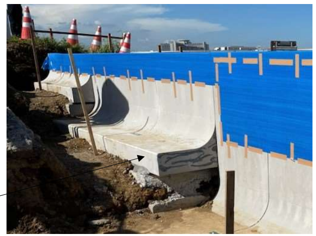
L型の擁壁底部を河川の外側から固定し、水圧に耐える構造
