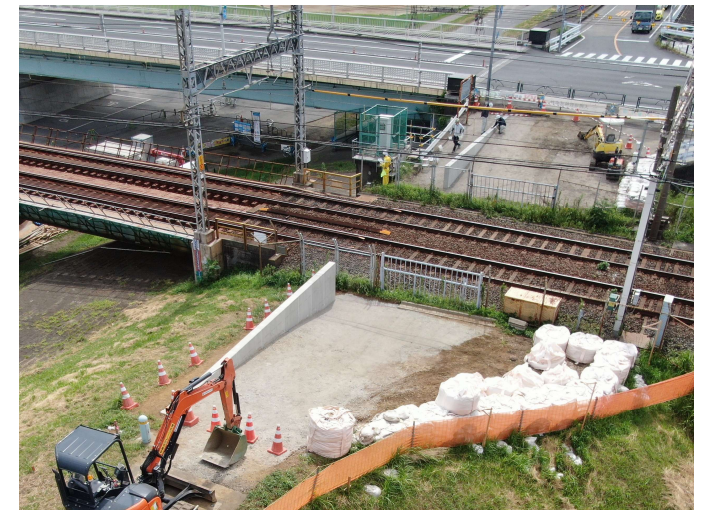
アスファルト舗装、侵入防止柵を設置して完成です。
