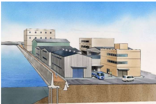
スーパー堤防整備前
