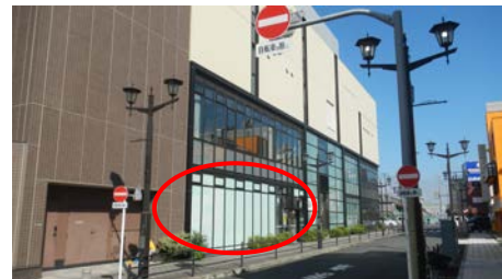
【南側からの全景】
