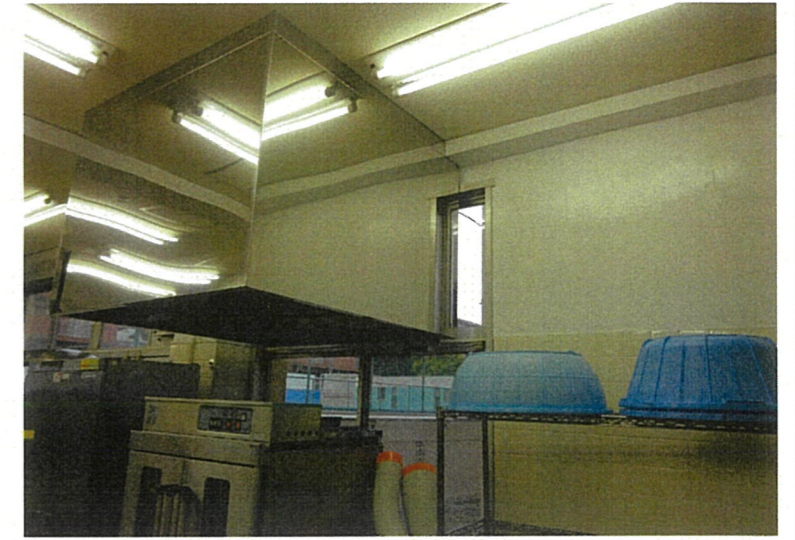
配管貫通箇所
