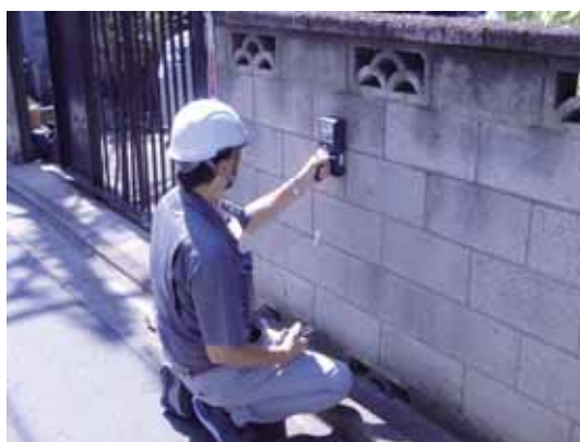
アドバイザー派遣制度を活用した詳細調査の様子
