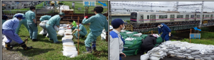
土のう設置作業【荒川右岸(足立区)】 土のう設置作業【荒川左岸(葛飾区)】
