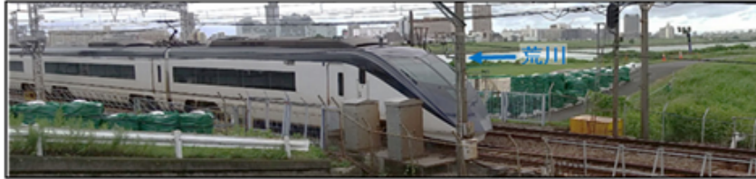
土のうの設置が完了した堤防の切り欠き部【荒川左岸(葛飾区)】
