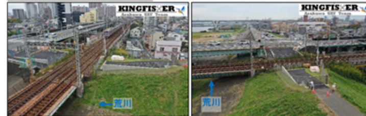
足立区側のパラペット(10m鉄道際から撮影)
