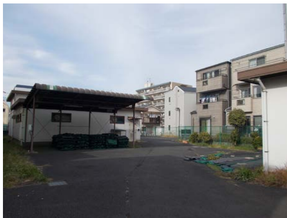
6 (旧) 綾瀬器材置場
