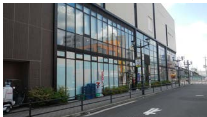
【南側からの全景】
