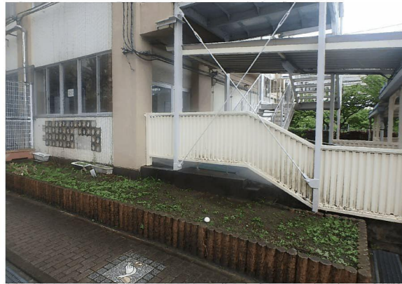
屋外機設置位置
