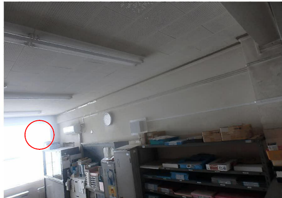
配管貫通部③
