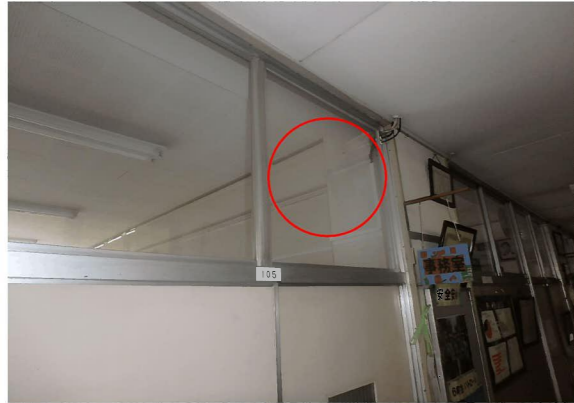
配管貫通部②
