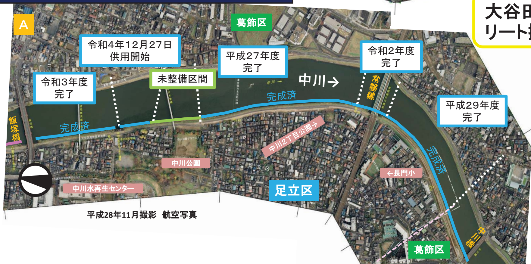
【下流側】中川の堤防整備状況(飯塚橋から中川橋)
