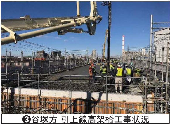
③谷塚方 引上線高架橋工事状況
