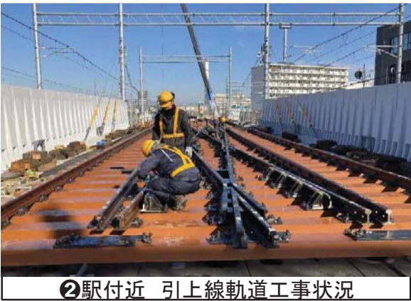
②駅付近 引上線軌道工事状況
