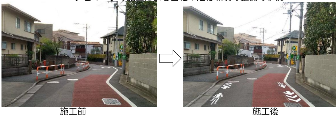
ナビマークの施工による自転車走行環境の整備の事例
