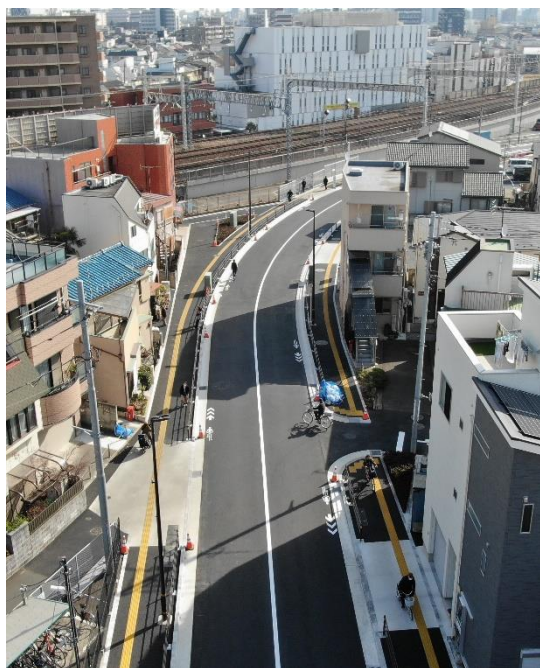
無電柱化された「主要区画道路2」沿道 (西新井栄町)
