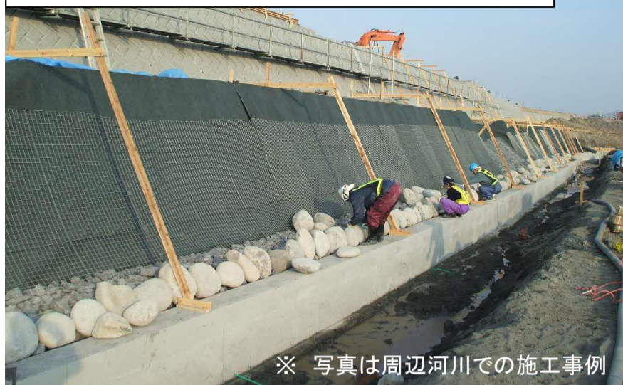
護岸工事(令和6年10月頃まで)
