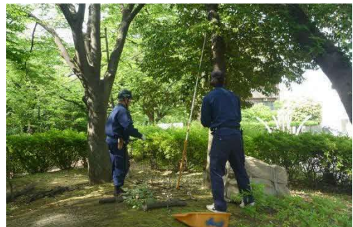
写真 枯れた枝を除去する様子
