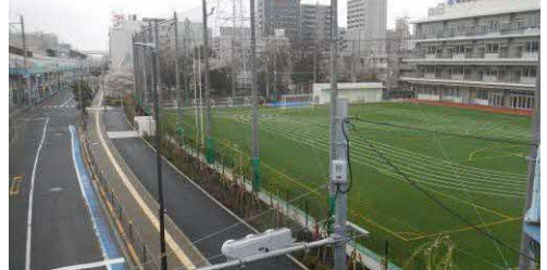
■改築後の綾瀬小学校及び駅前通り
