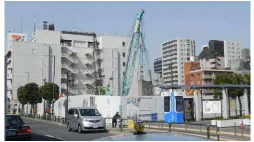
■綾瀬駅東口の駅前開発地及び交通広場予定地
