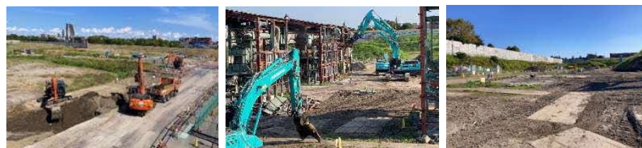
敷地造成(掘削)状況
