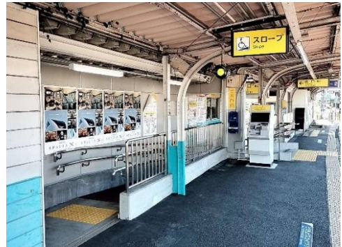
堀切駅に設置されたスロープ
