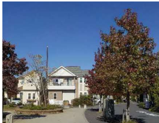
公園と道路が一体に整備された公園 （東六月町ふれあい公園）
