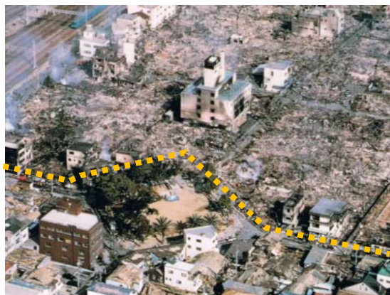
火災発生時に焼け止まりとなった 公園（阪神淡路大震災）
