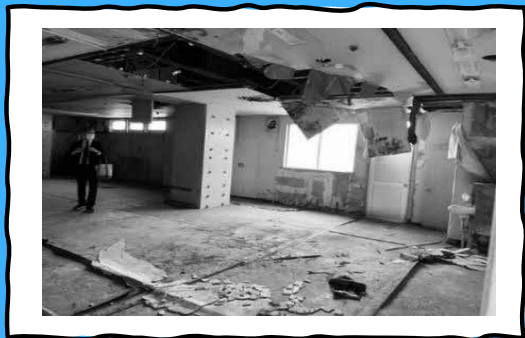
▲ 綾瀬駅西口高架下空き店舗の現状
