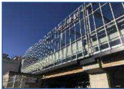
新駅舎建築工事の状況
