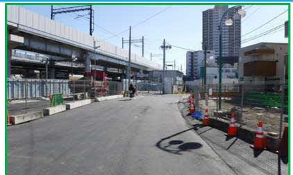
電線共同溝工事実施箇所
