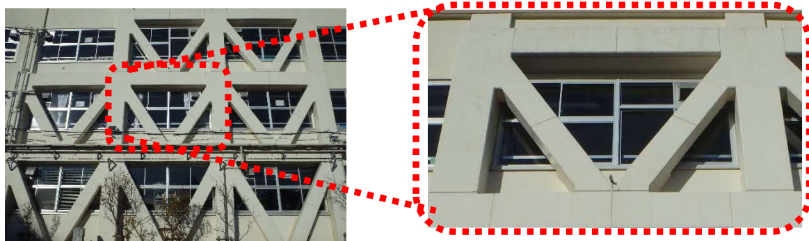
緊急輸送道路沿道建築物と同規模の建築物における耐震改修事例
