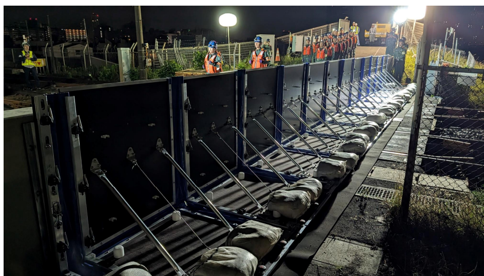
止水板設置完了（河川側）
