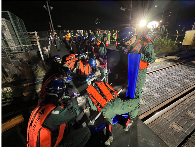
止水板設置状況（組立）
