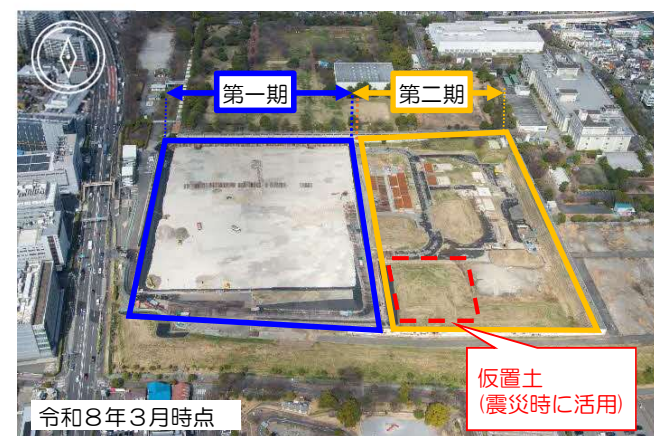
【震災時の応急復旧対応（埋戻し用の土）】
