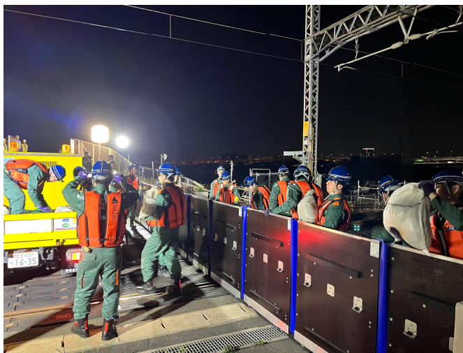
止水板設置状況（押さえ土のう設置）
