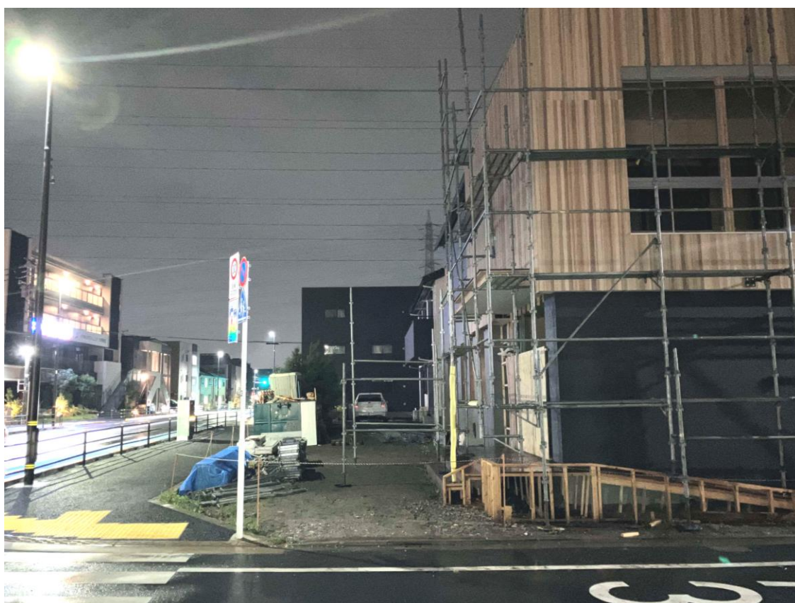
▲ 足場撤去完了後の様子
