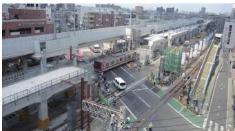
・鉄道高架化の工事が進行中
