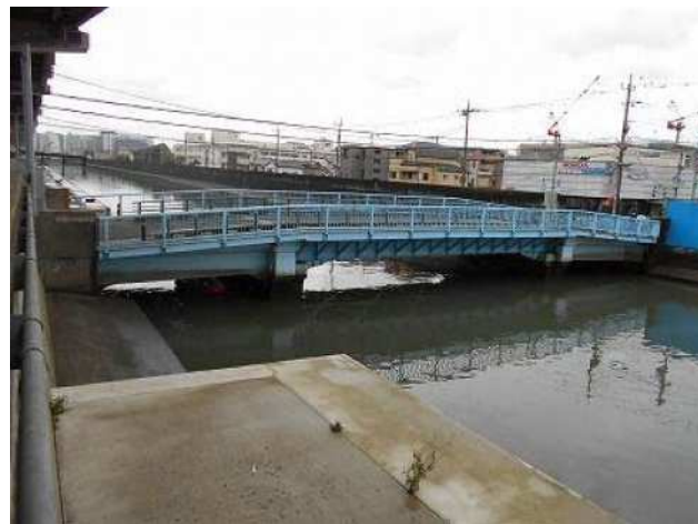
図5 14 t車規制の築90年の綾瀬新橋
