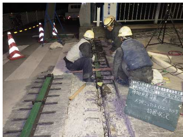
図10 花畑大橋の伸縮装置交換工
