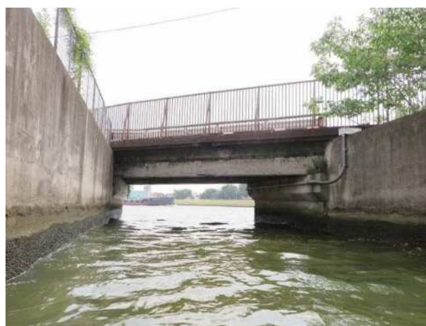
図4 3 t車規制の築93年の花見橋
