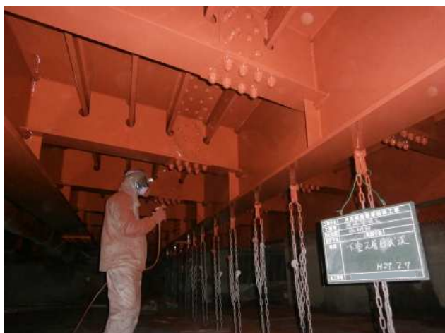
図9 月見橋の塗裝修繕工事
