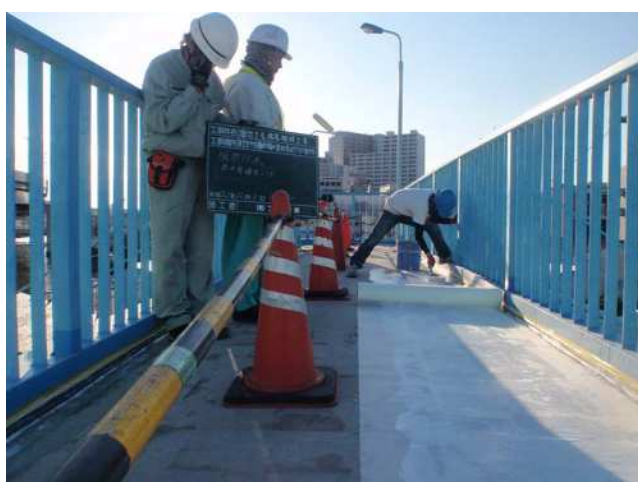
図11 堀切駅跨線人道橋の修繕工事
