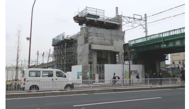
②公園北側道路
