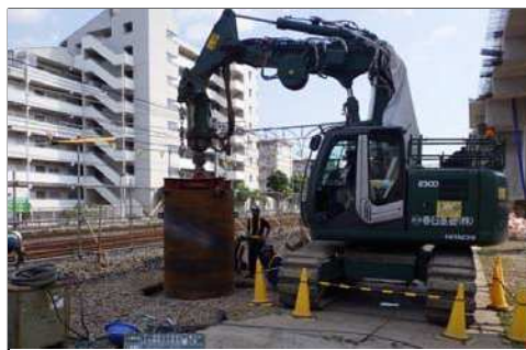
①Ⅱ工区基礎杭工事状況
