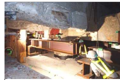
③Ⅲ工区橋上駅舎仮受鋼材設置状況
