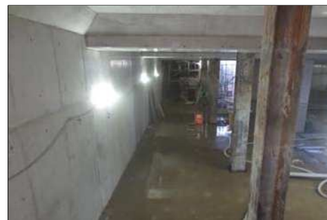
②仮設地下自由通路工事状況
