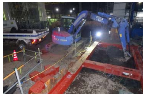
①高架橋基礎工事(掘削)状況
