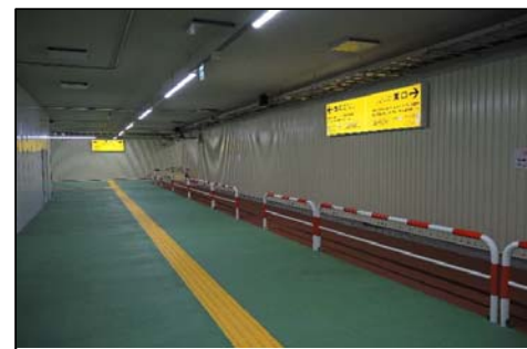
②仮設地下自由通路工事状況(通路部)
