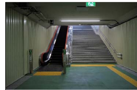
③仮設地下自由通路工事状況(階段部)
