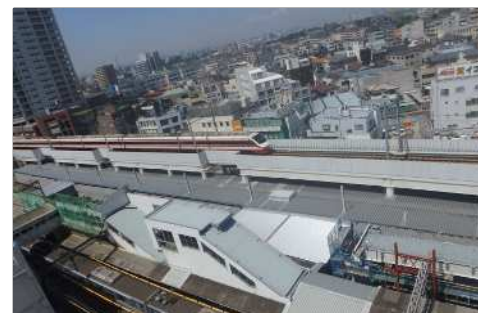
② 駅付近の工事状況
