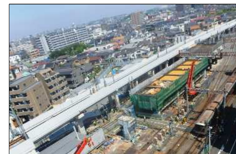
③ 駅北側の工事状況
