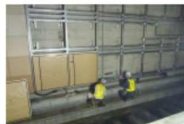
対向壁の設置（南流山駅工事時）
