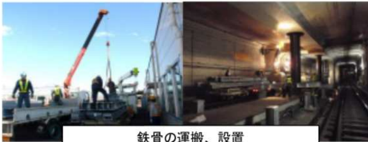
鉄骨の運搬、設置
