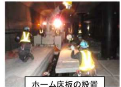
ホーム床板の設置
