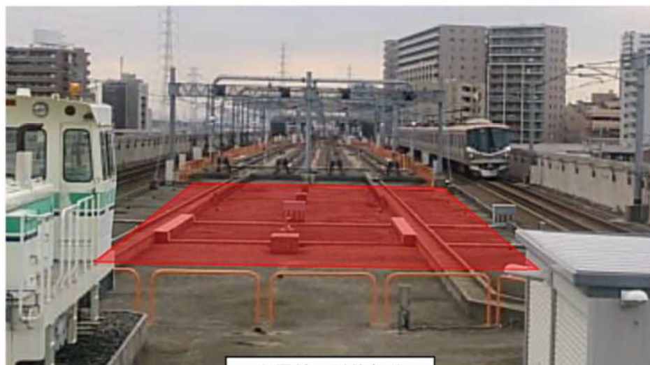
留置線の延伸部分
