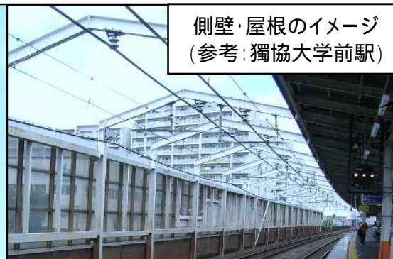
屋根の設置は ホーム上部のみ
