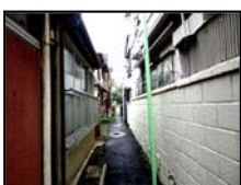
19 狭すぎる道に高いブロック塀
