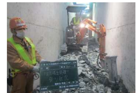
掘削範囲の固化状況
