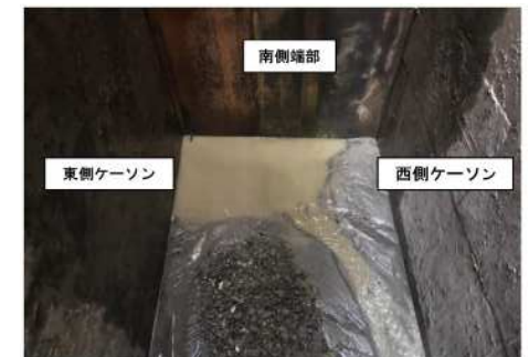
掘削範囲の固化状況
