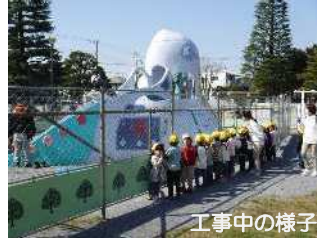
工事中の様子
