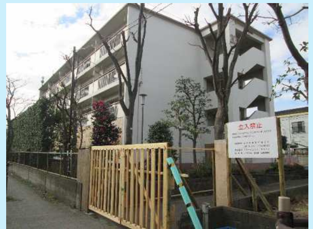
解体予定の新田三丁目区営住宅(1階部分仮囲い)
