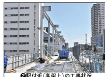
②駅付近(高架上)の工事状況
