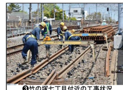
③竹の塚七丁目付近の工事状況
