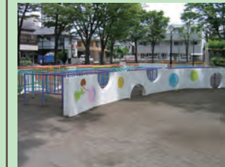
改修した公園の例
