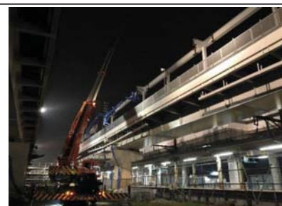
②新駅舎施工状況
