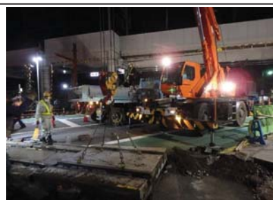
①大踏切部仮上り急行線の軌道撤去状況
