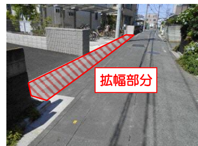
道路の拡幅整備後
