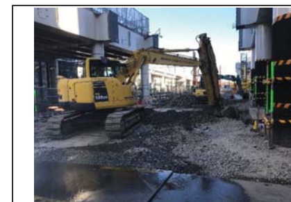
③補助261号線付近 躯体施工状況
