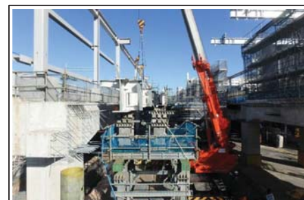
②新駅舎施工状況
