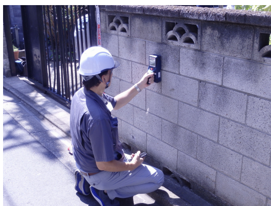
アドバイザー派遣制度を活用した詳細調査の様子
