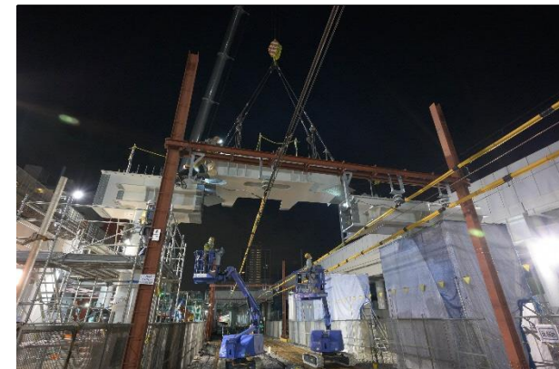
③竹の塚六丁目付近 工事状況
