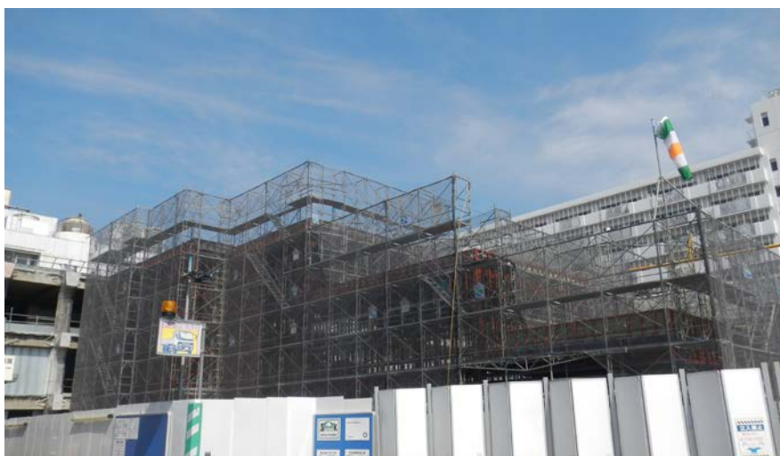
【仮設階段等の工事状況写真（令和4年3月1日現在）】
