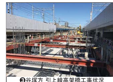
③谷塚方 引上線高架橋工事状況
