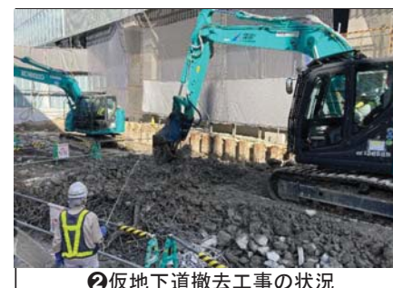
②仮地下道撤去工事の状況
