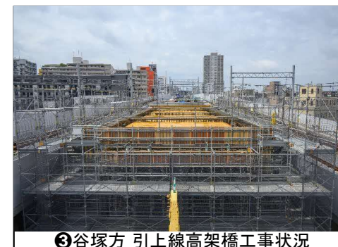
③谷塚方 引上線高架橋工事状況
