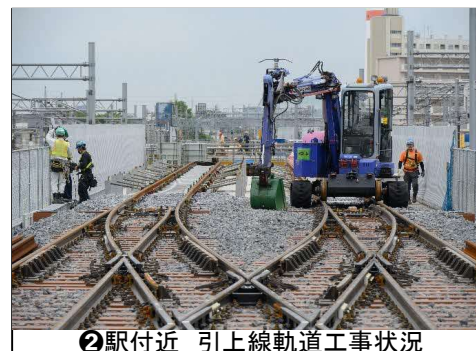
②駅付近 引上線軌道工事状況
